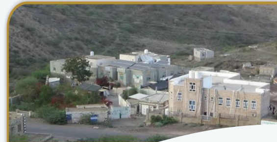
مبنى رقم ٢ الطوارئ العامة والتوليدية
