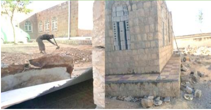
بناء صالة عمليات و غرفة افاقة
